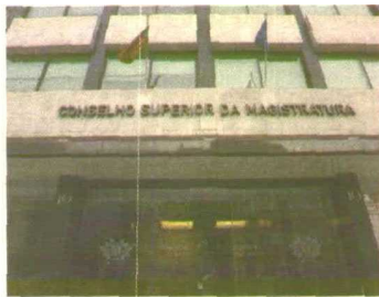
CSM justifica adiamento da acórdão da Casa Pia pela complexidade do caso
